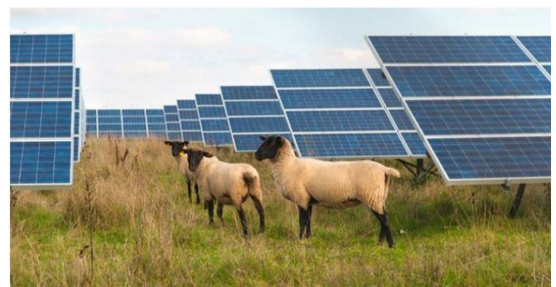
Exemple de centrale photovoltaïque avec éco pâturage
